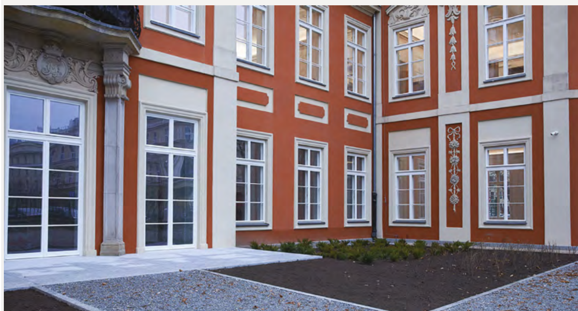
Elewacja Pałacu Czapskich po remoncie / Fot. Paulina Brzezińska Photo Paulina Brzezińska
