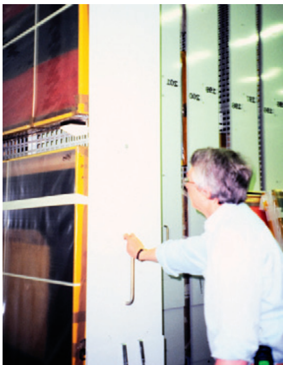
50. Klimatyzowane magazyny z mobilnymi kratami dla obrazów, które są osłonięte i zabezpieczone. Fot. archiwum Iwony Szmelter
